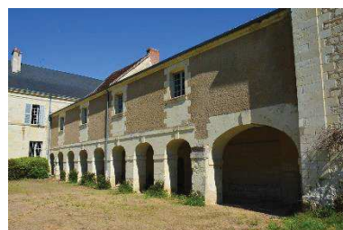
Vestiges de l'élévation occidentale du cloître. IVR75_20188606776NUCA
