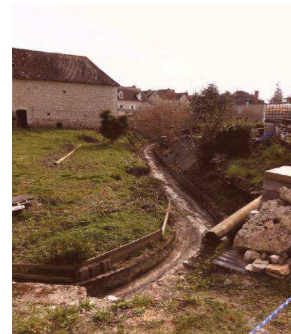
Le cours canalisé de l’Arceau
